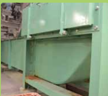
灰は、薬品で無害化処理され、コンベアで運ばれて灰バンカに貯められます。
