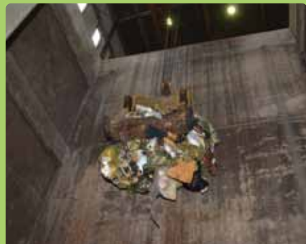
ごみピットからクレーンで、焼却炉までごみを運びます。
