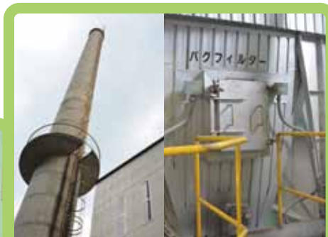
排ガスはバクフィルタなどで有害物質などを取り除き、クリーンな状態で煙突から放出されます。
